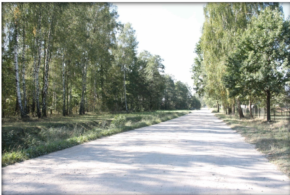
Fot. 2. Drogi powiatowej nr 4307W
